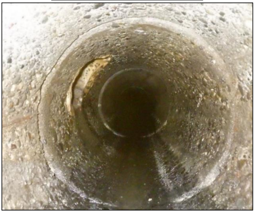
老朽化した管（施工前）
