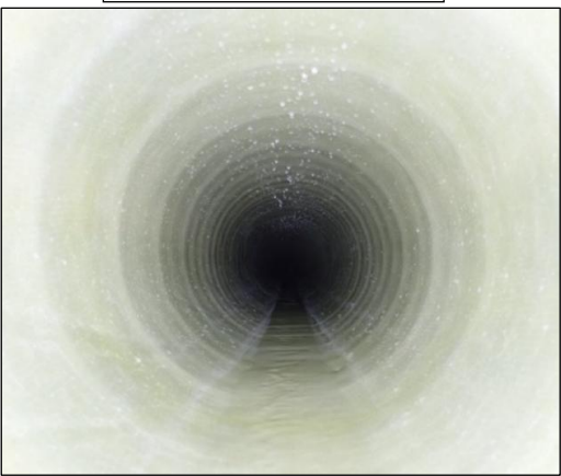
管更生した管（施工後）
