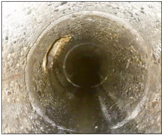
老朽化した管（施工前）
