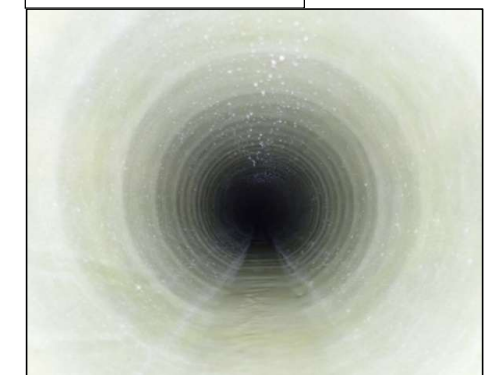
管更生した管（施工後）
