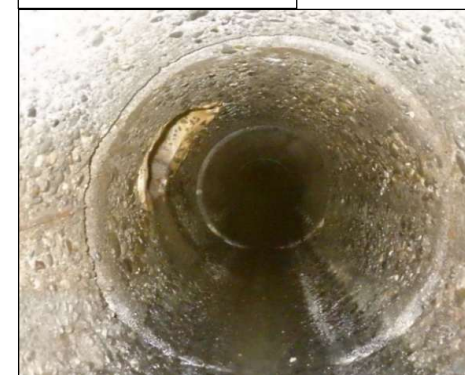
老朽化した管（施工前）
