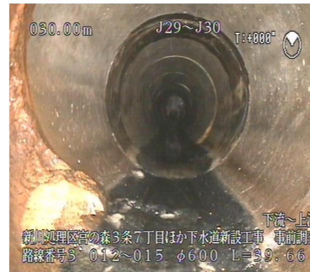
【管更生施工前】
