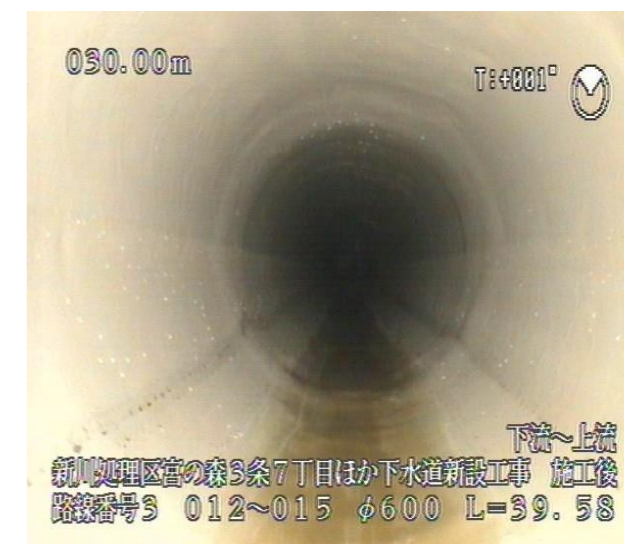
【管更生施工後】
