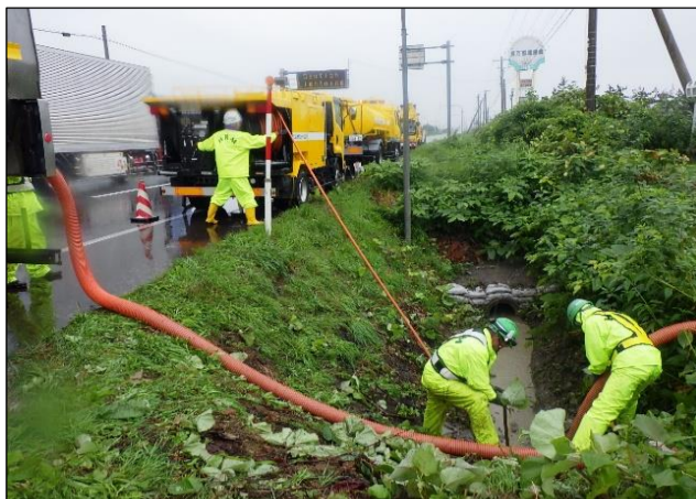
管渠清掃工事
