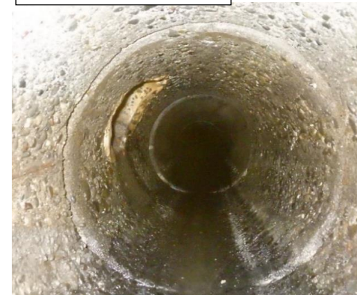
老朽化した管（施工前）
