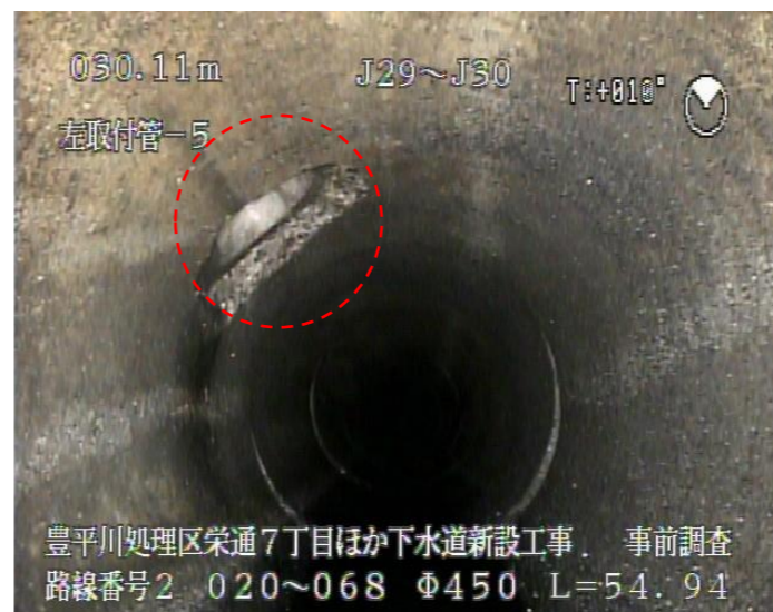
【管更生施工前】
