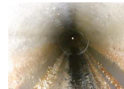
管更生前 (老朽管)
