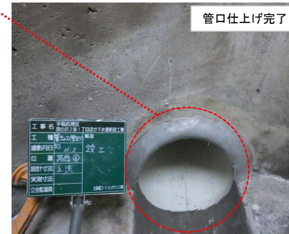
• 作業状況全景とマンホール内の管更生後の管口仕上げ完了状態。
